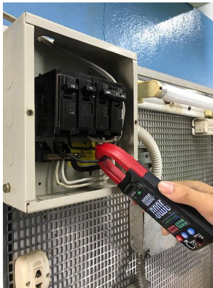
รูปที่ 9.10 วัดกระแสไฟฟ้าด้วยแคลมป์-ออน แอมมิเตอร์
