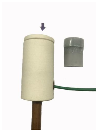
รูปที่ 10.7 การเชื่อมสายดินเข้ากับหลักสายดินโดยใช้ผงเชื่อม
