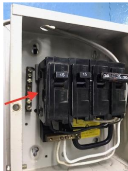
รูปที่ 8.3 การติดตั้งเซอร์กิตเบรกเกอร์แบบ 1 ขั้วในแผงย่อย
