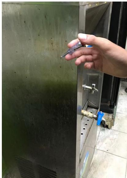
รูปที่ 9.8 การตรวจสอบอุปกรณ์ไฟฟ้ารั่วลงดิน
