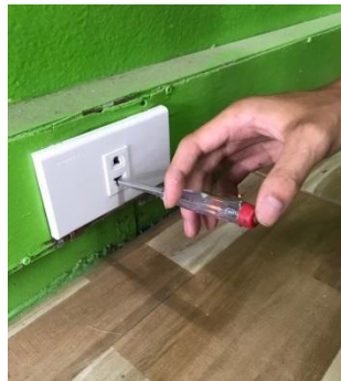
รูปที่ 9.5 การตรวจสอบสายมีไฟ (L) ในเต้ารับโดยใช้ไขควงเช็คไฟ
