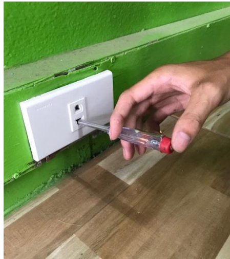
รูปที่ 11.6 การตรวจสอบการไหลของไฟฟ้าด้วยไขควงเช็คไฟในเต้ารับ
