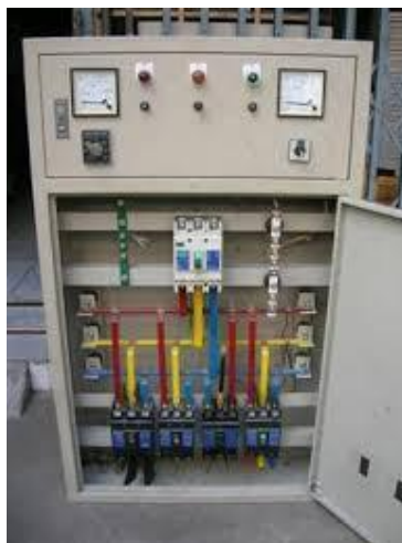
รูปที่ 8.19 การติดตั้งส่วนของอุปกรณ์ป้องกัน
