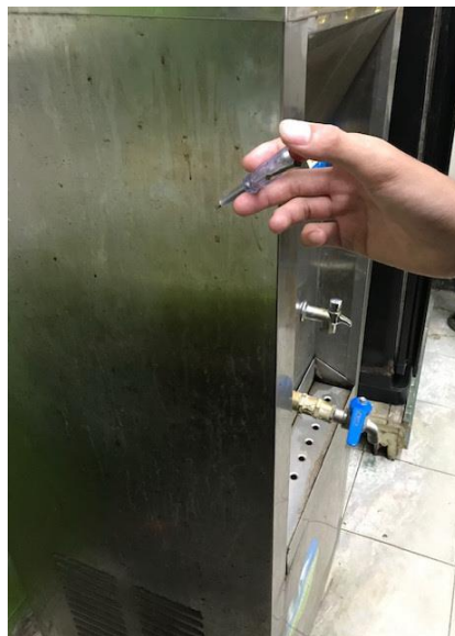
รูปที่ 9.8 การตรวจสอบอุปกรณ์ไฟฟ้ารั่วลงดิน
