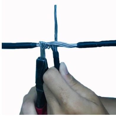
รูปที่ 2.8 การต่อสายตีเกลียวแยก 3 ทาง
