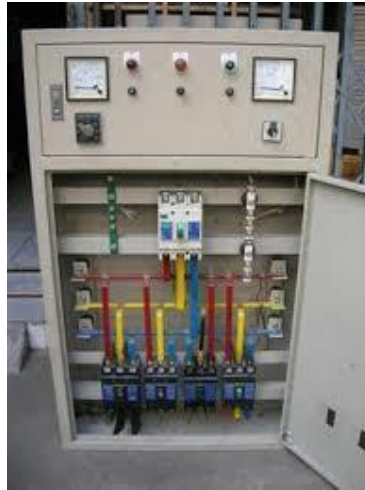
รูปที่ 8.19 การติดตั้งส่วนของอุปกรณ์ป้องกัน
