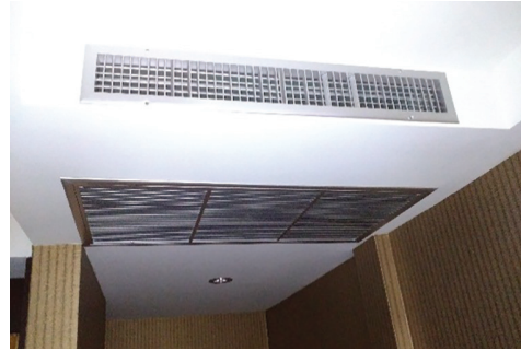
เมื่อติดตั้งเสร็จ
