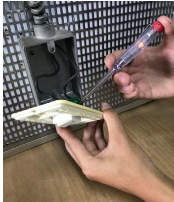
รูปที่ 9.4 การตรวจสอบสายมีไฟ (L) ในสวิตช์โดยใช้ไขควงเช็คไฟ
