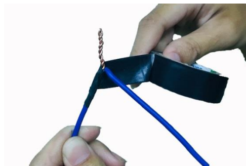
รูปที่ 2.10 การพันเทปพันสายต่อแบบหางเป็ด
